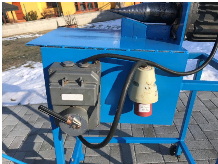
Obr. č. 4 Elektroinštalácia [foto: Jahoda, A., 2019]
