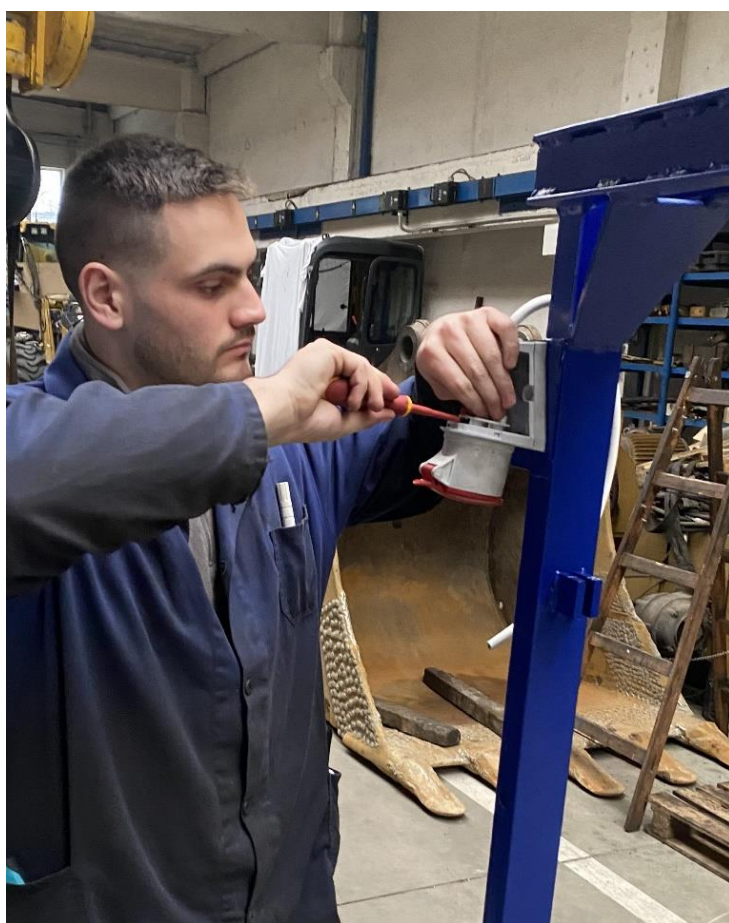
Montáž 32A zásuvky na rám ( Zdroj, Pohlod, D., 2023)
